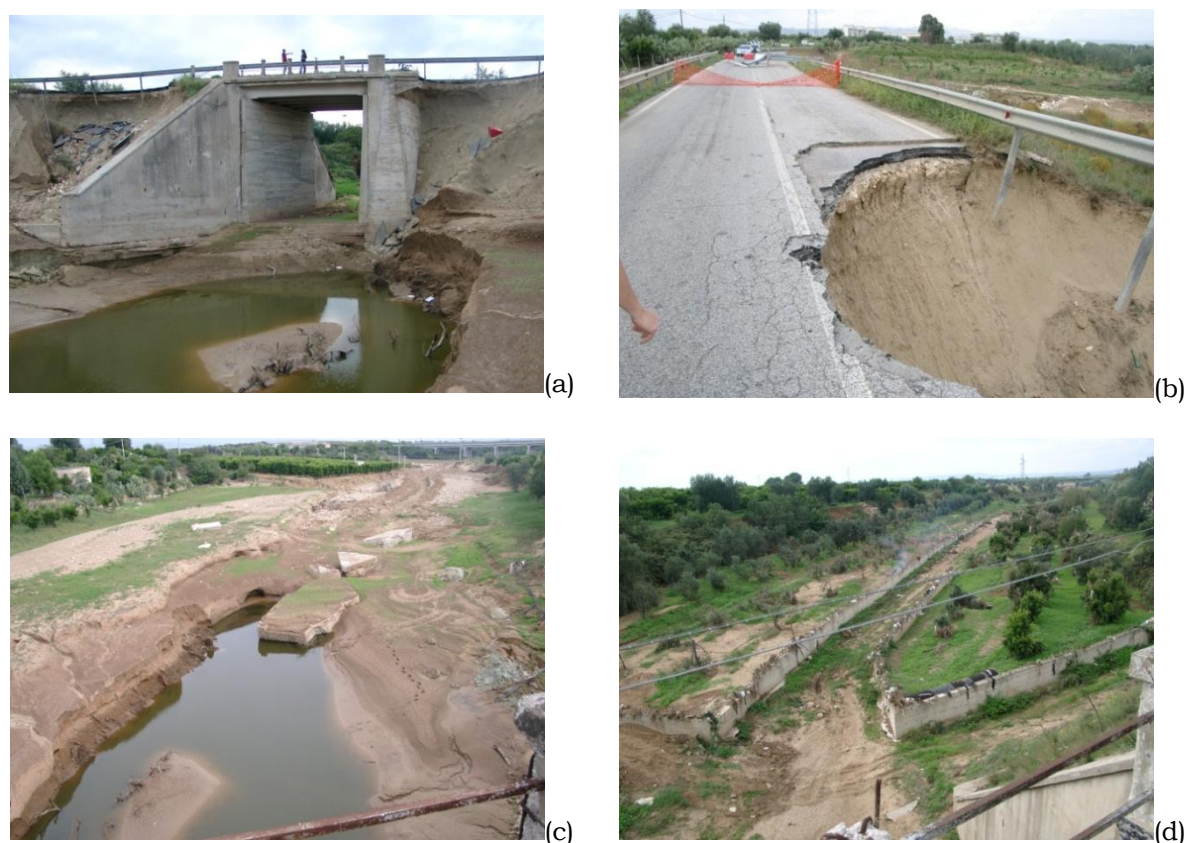
Figura 3.4 - Cedimento del rilevato stradale -Palagianello (TA)
