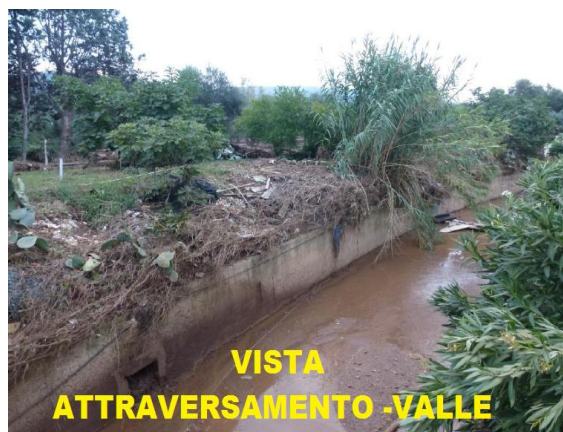
Figura 3.14 - Sormonto del ponte e trasporto di fango - attraversamento GA00000072SS - Peschici (FG)
