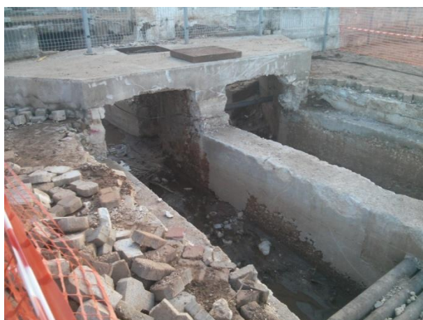
Figura 3.19 - Cedimento del corpo stradale lungo il tratto tombato alla foce Canale del Pincio - Rodi Garganico (FG)
