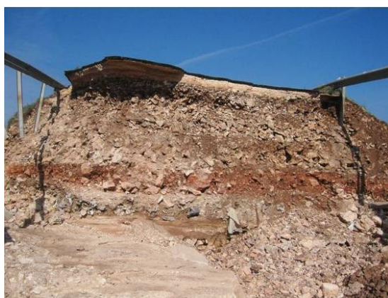
Figura 3.8 - Crollo del ponte stradale - attraversamento BA01900200SP - Cassano delle Murge (BA)
