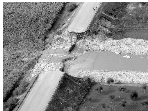
Figura 3.8 - Crollo del ponte stradale - attraversamento BA01900200SP - Cassano delle Murge (BA)
